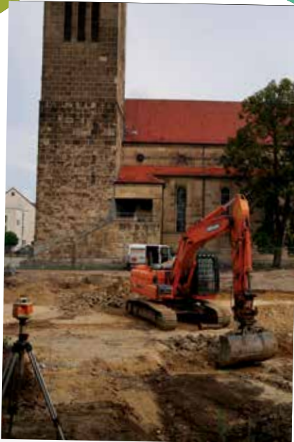
Baubeginn neues Gemeindehaus Elisabeth
